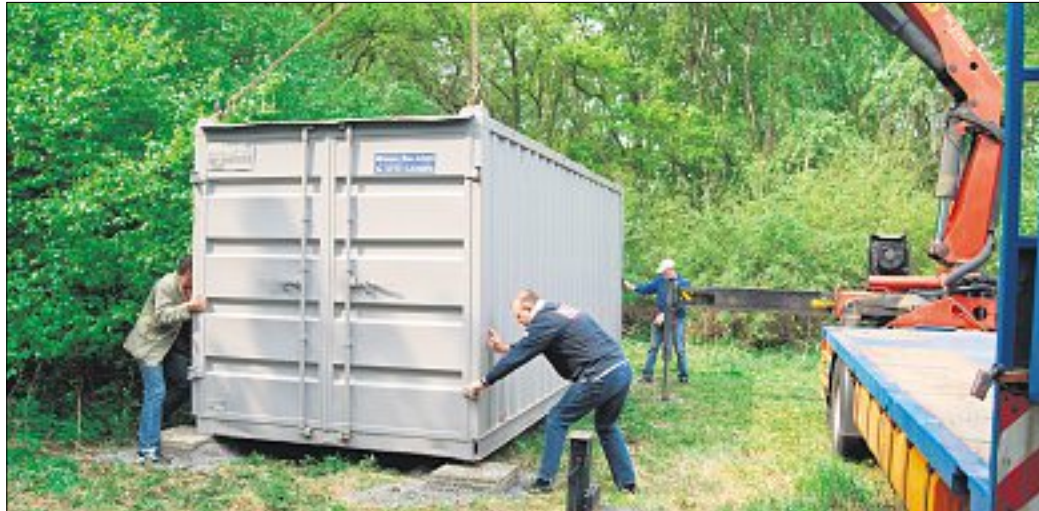
Maßarbeit: Wilhelm Behrens hilft beim Aufsetzen des Containers auf die Fundamente.
